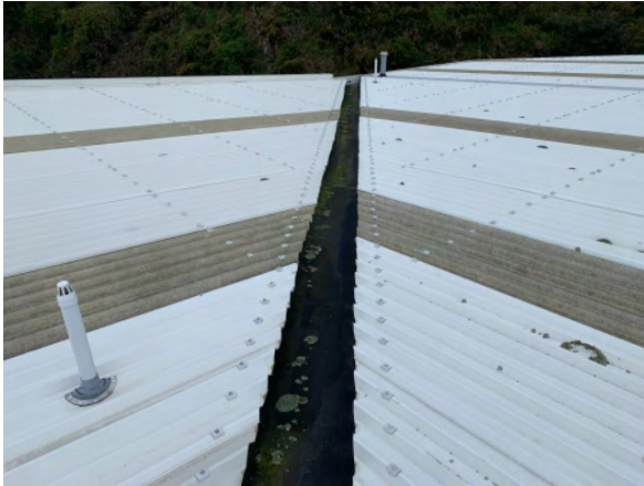
Butynol gutter overview
