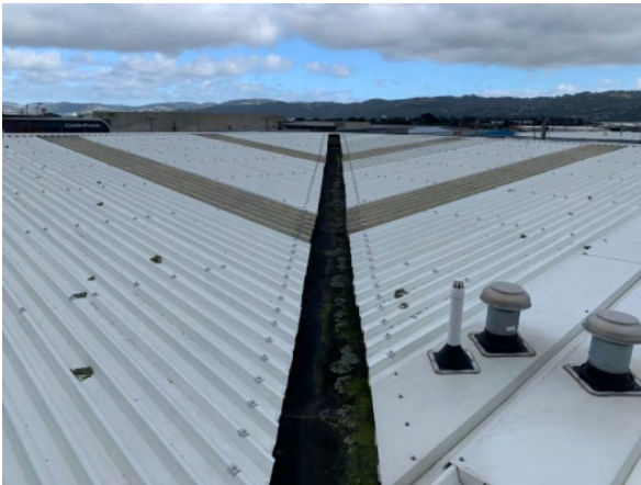
Butynol gutter overview
